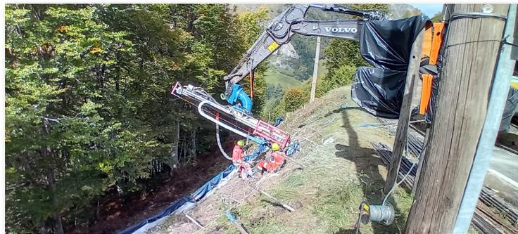
L'apparition, fin 2023, d'une fissuration importante sur la chaussée de la route du col du Somport d'environ 12 m de longueur et 10 cm de profondeur, a nécessité la mise en place de mesures d'exploitation contraignantes. Après une campagne de reconnaissances géotechniques, des travaux de clouage, visant à sécuriser le talus supportant la chaussée, ont été réalisés à l'aide de 750 ml de clous et de 250 m<sup>2</sup> de filet stabilisateur, pour un montant de 210 k€.
