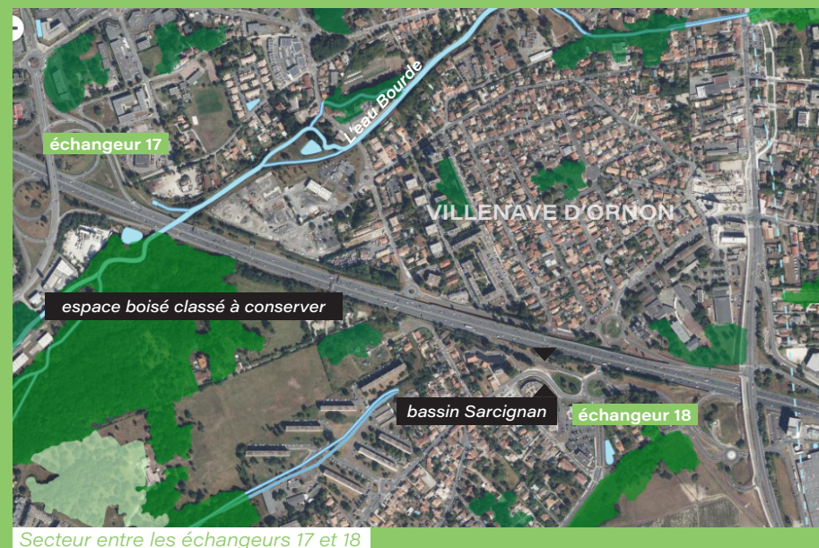
Secteur entre les échangeurs 17 et 18
