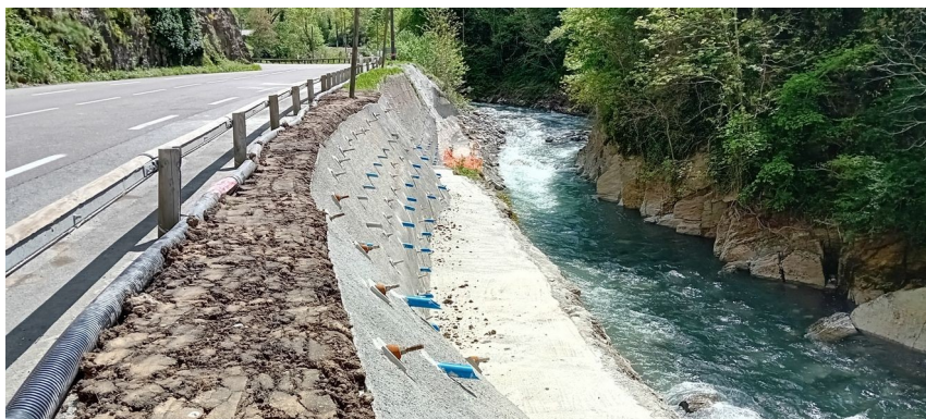
Figure 41: travaux de confortement réalisés
