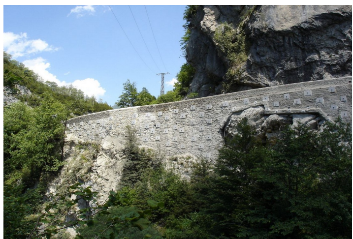
Figure 11: zone après travaux
