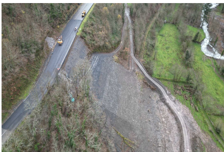
Figure 42: brèche comblée, travaux de chaussées finis
