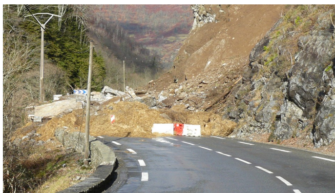
Figure 18: éboulement de janvier 2008
