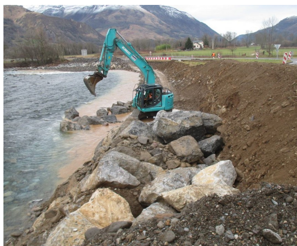
Figure 9: confortement d'une berge du gave d'Aspe en enrochements
