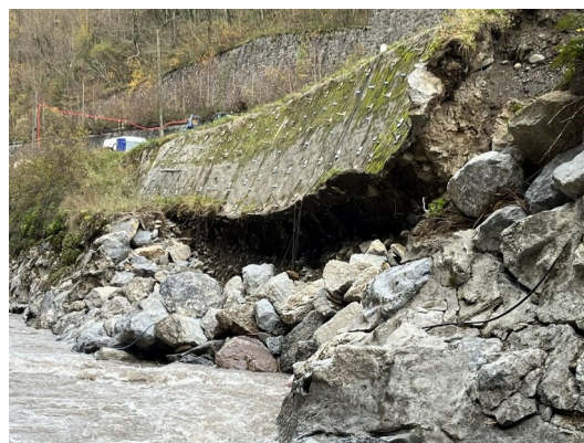
Figure 39: paroi clouée suspendue
