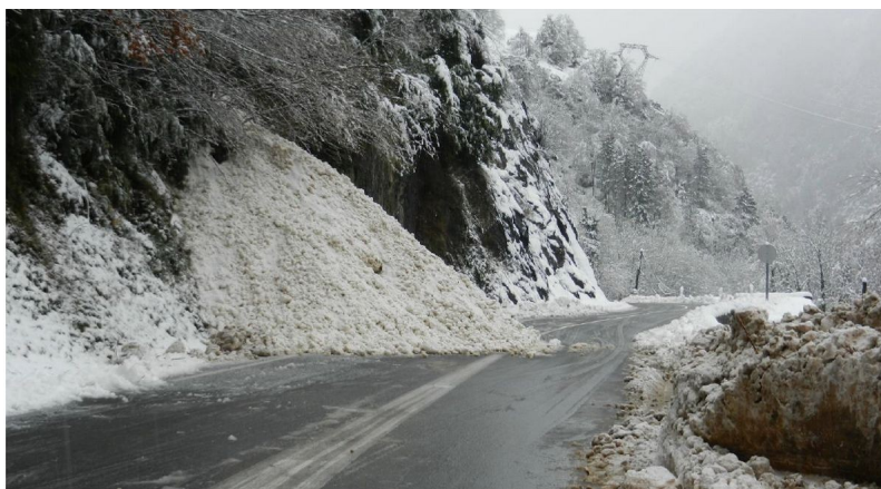
Figure 2: pied du couloir de Tranchère le 15/01/2013, sur la RN134
