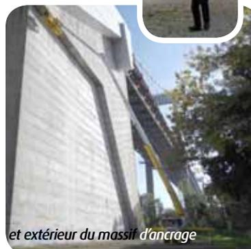
et extérieur du massif d'ancrage
