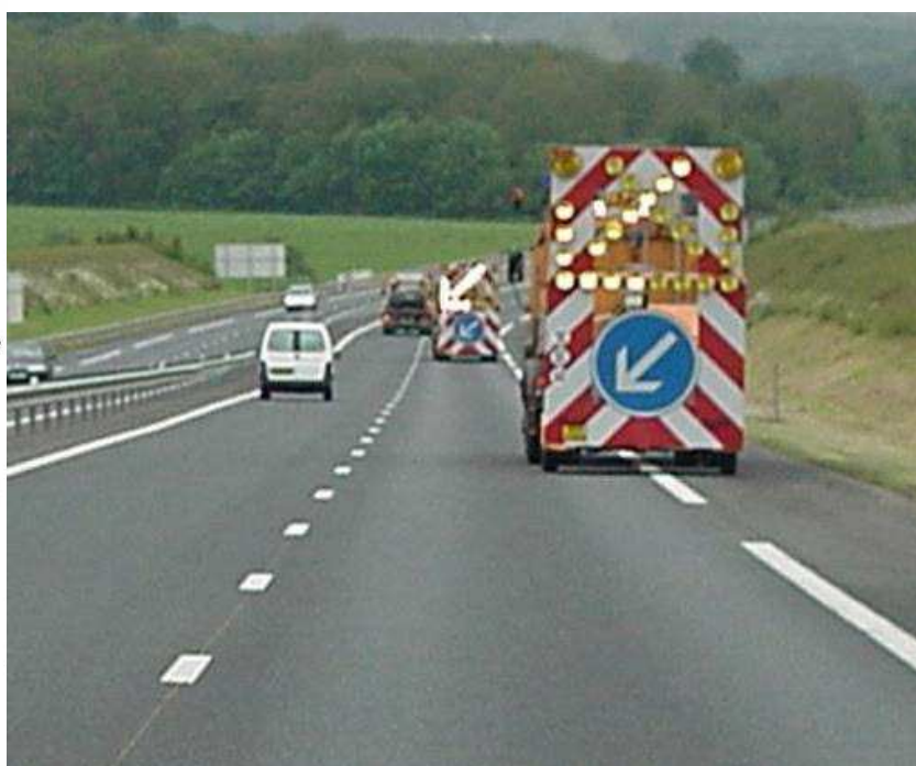
Neutralisation de voie de droite par FLR – crédits CETE de l'Ouest
